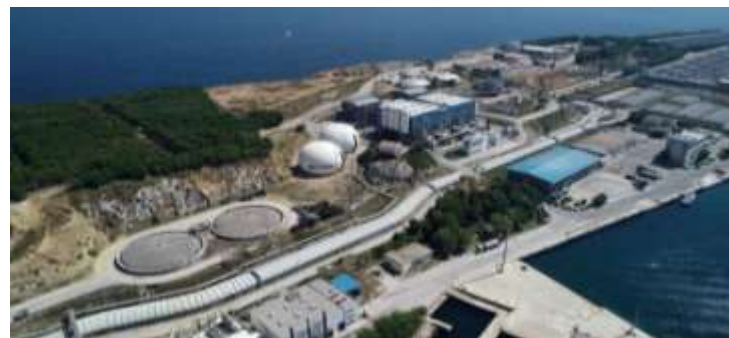
Σταθμός βιοαερίου στο κέντρο επεξεργασίας λυμάτων της Ψυτάλλειας – ΕΥΔΑΠ (11,4 MW)
