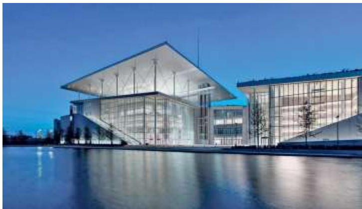
ΦΒ στο στέγαστρο του Κέντρου Πολιτισμού του Ιδρύματος Σταύρος Νιάρχος (1,65 MW)
