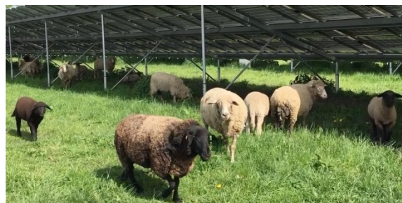
Τυπικά παραδείγματα φωτοβολταϊκών πάρκων
