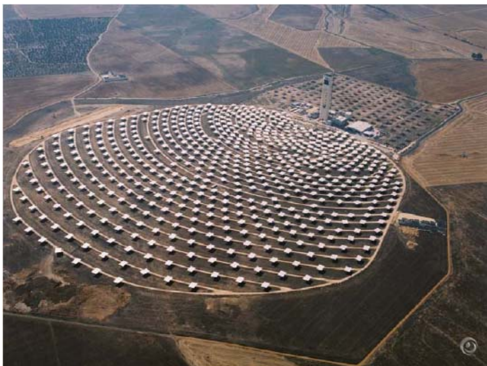
Ηλιοθερμικός σταθμός ηλεκτροπαραγωγής 10 MW στην Ισπανία
