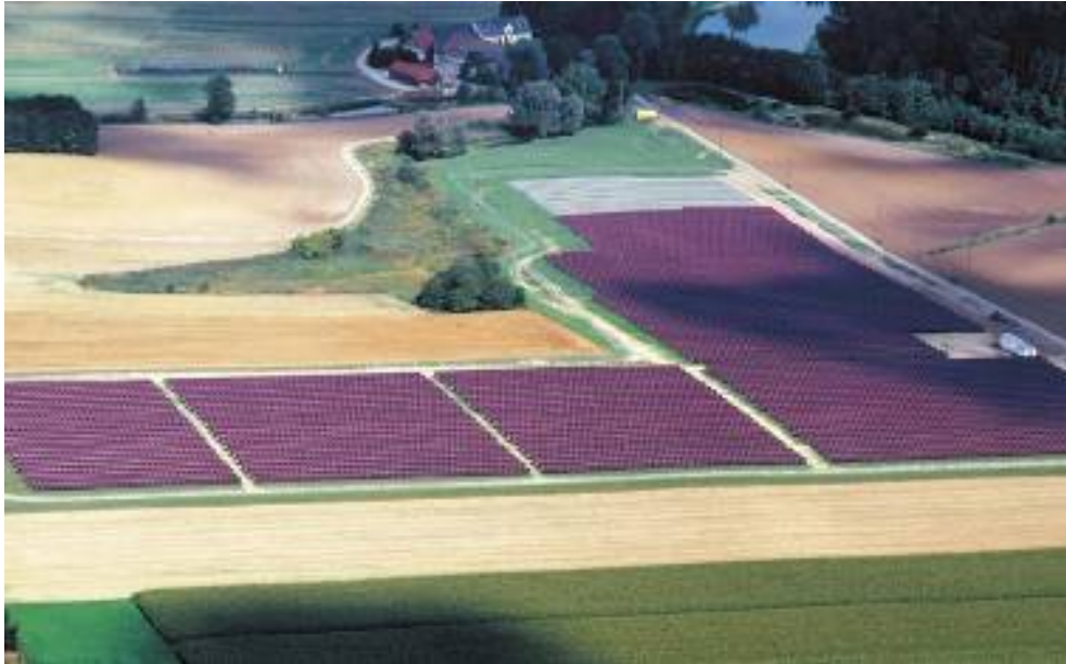
Φωτοβολταϊκός σταθμός τεχνολογίας άμορφου πυριτίου ισχύος 1 MW σε αγροτική περιοχή της Γερμανίας
