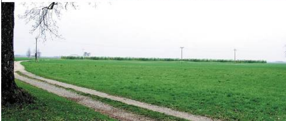
Ο φυτοφράχτης (κάτω φωτογραφία) “προστατεύει” οπτικά τον περικλειόμενο φωτοβολταϊκό σταθμό
