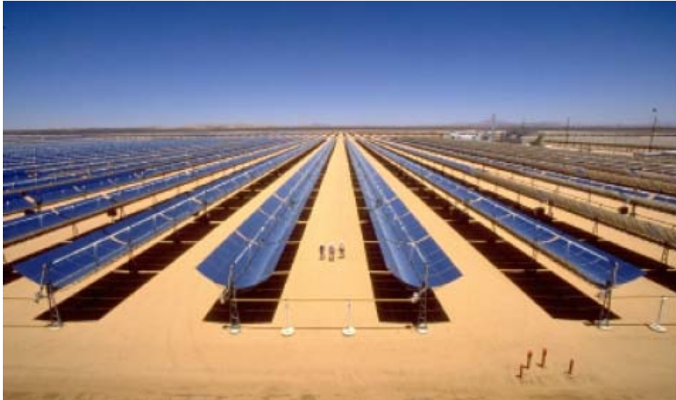
Ηλιοθερμικός σταθμός ηλεκτροπαραγωγής 50 MW στην Καλιφόρνια
