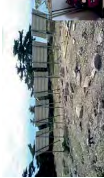
Καταφύγιο Πάρνηθας, θέση Φλαμππούρι. Αυτόνομο ΦΒ σύστημα
